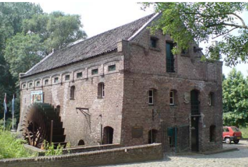
Het voormalige oliemolen gedeelte van de gereconstrueerde Wijmarse watermolen van Arcen (Lb) is herbestemd als ambachtelijke graanbranderij en schenkerij.
