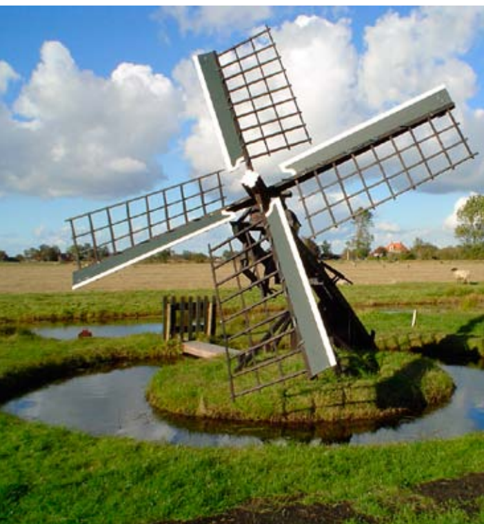
De tjasker is een klein type poldermolen voor het bemalen van kleine percelen land.
