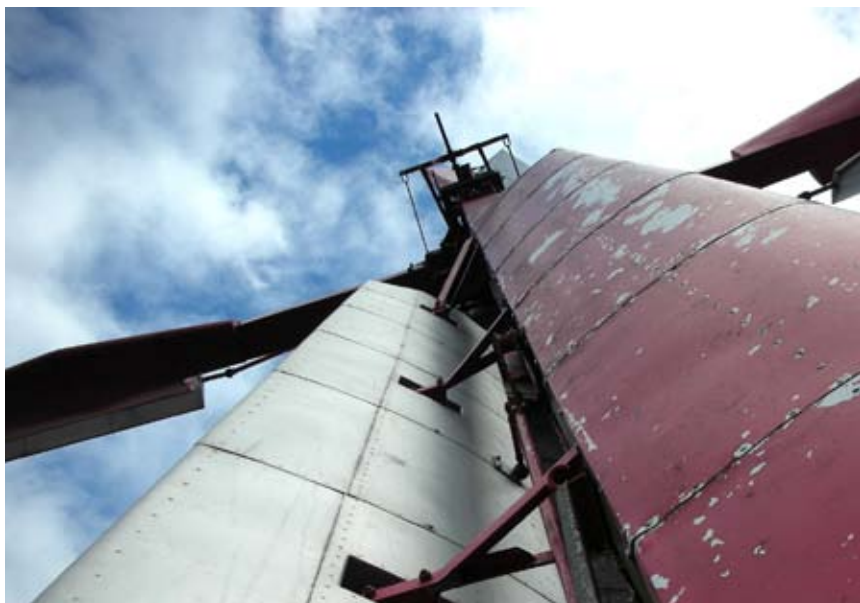
De Bilauwieken van molen De Hoop te Norg (Dr), zijn de enige originele overgebleven van hun soort.
